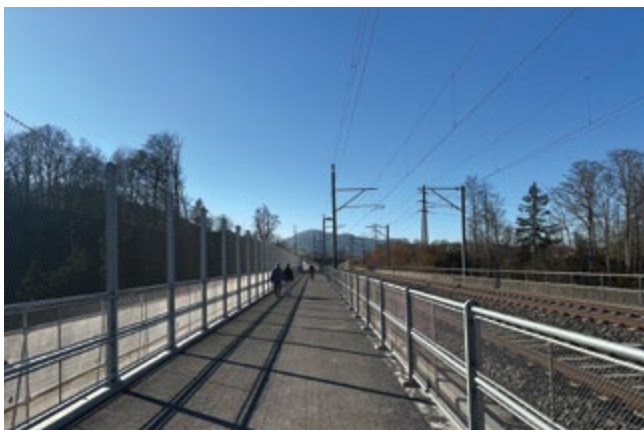
Schlüsselprojekt Verbreiterung der SBB-Sitterbrücke
